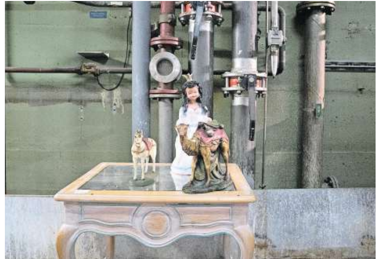
Der «Gedächtnispalast» entsteht in Emmenbrücke.
